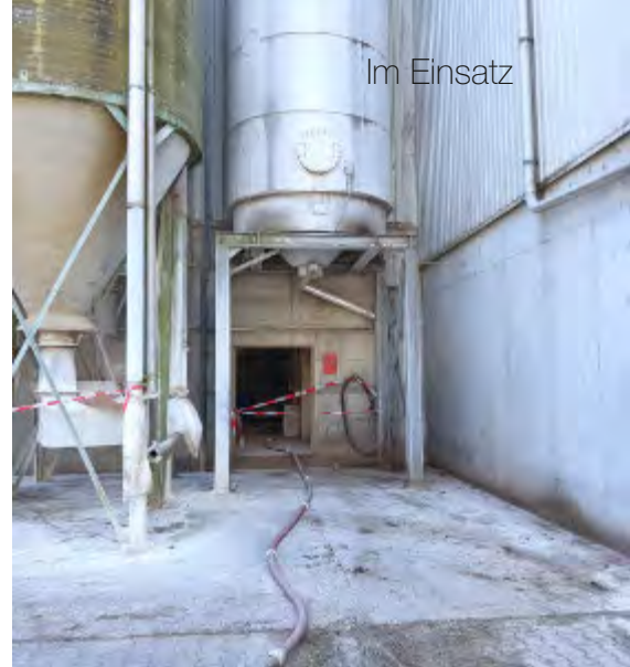
Die Stickstoffleitung führt in die Mühle.
